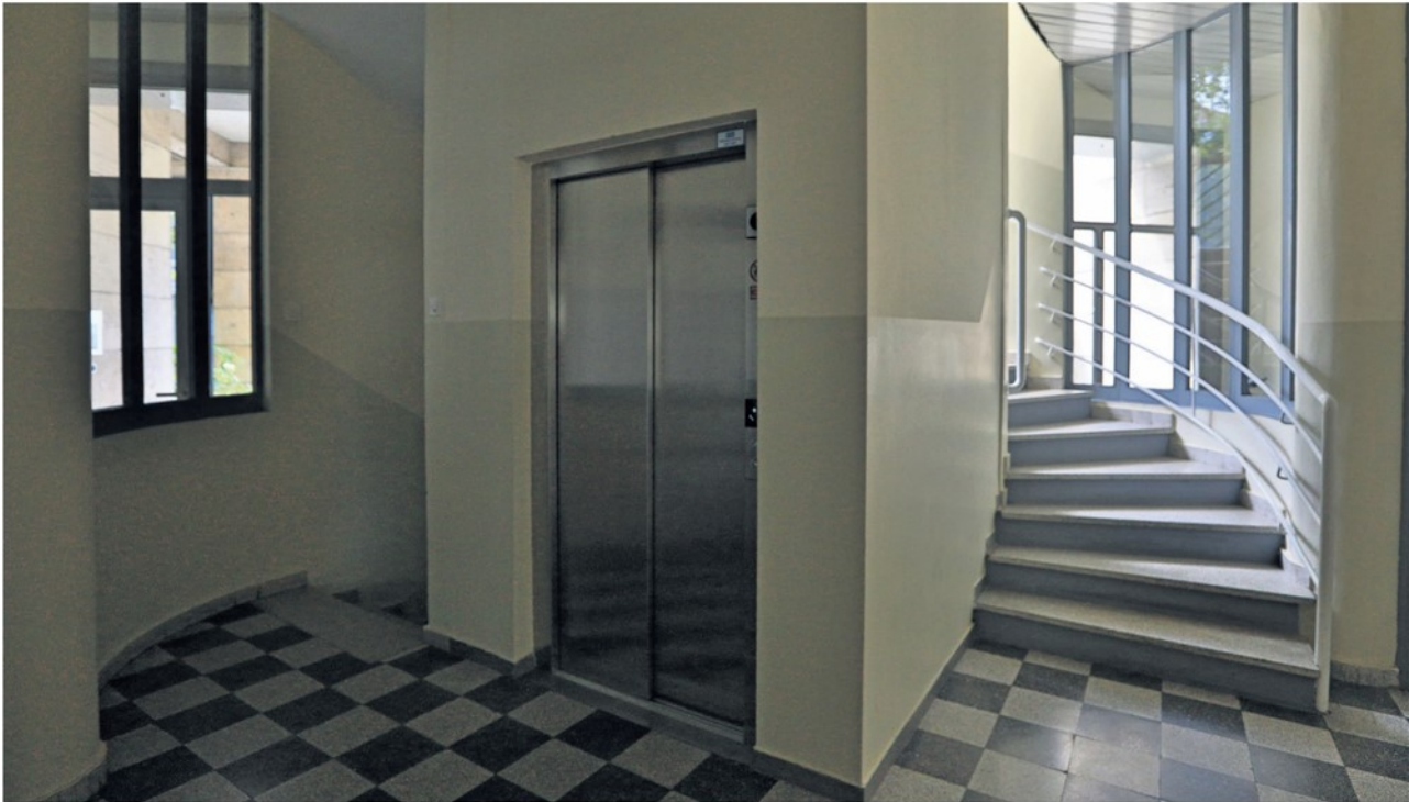
Dvigala so nujno potrebna za invalide, starejše in bolnike, ki sami hoje po stopnicah ne zmorejo. Foto: Andrej PETELINŠEK
